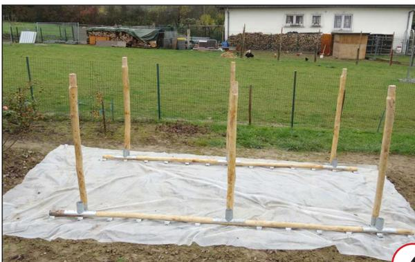
**4** **Wichtig:** Einschlagbodenhülsen setzen: Um die genaue Position für das Setzen der Bodenhülsen zu ermitteln, benutzen Sie die bereits vorgefertigten Elemente aus dem letzten Schritt. Der Abstand der Pfosten muss auf
