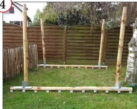
Die 4 Einschlagbodenhülsen können einbetoniert werden, um die Stabilität zu verbessern. (Windlasten / Standsicherheit)
