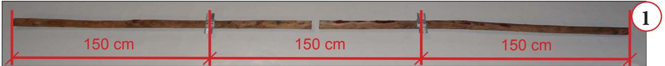
**1** Zuerst werden 2 Holzverbinder auf die Pfetten geschraubt. Wie auf dem Bild zu sehen genau 1,50 m vom äusseren Ende der Pfetten. Schrauben 8 x 30mm
